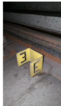
Bild links: Kennzeichnung des geerdeten Gleises
